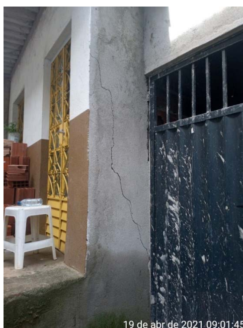
Figura 6: Trinca em residência próxima à encosta.
